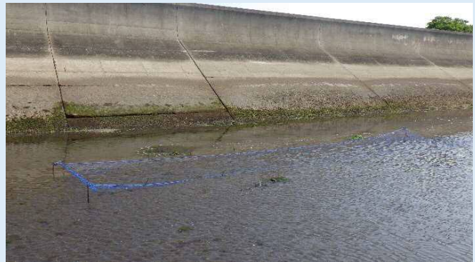
写真1 ノリ網を設置して天然採苗(2022年6月2日撮影)
